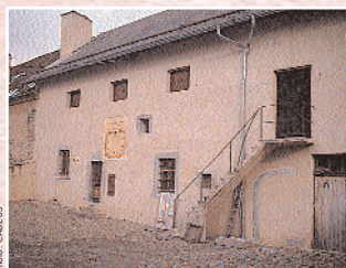
Réhabilitation dans le Champsaur
