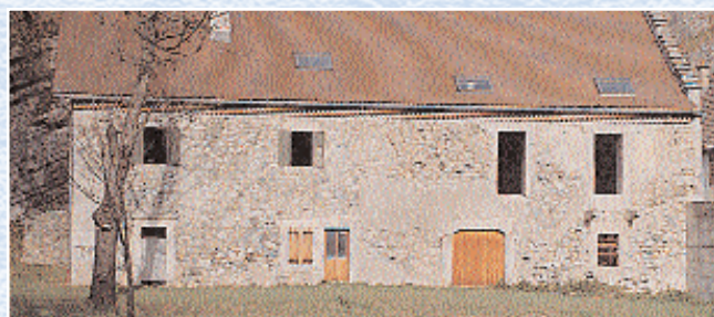
Réhabilitation d'un bâtiment ancien à Saint-Firmin
