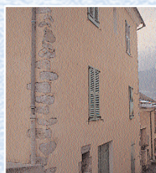
Réhabilitation de façade
