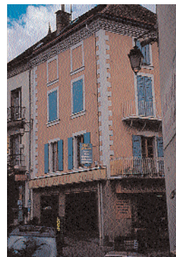
Traitement de façade en angle de rue
