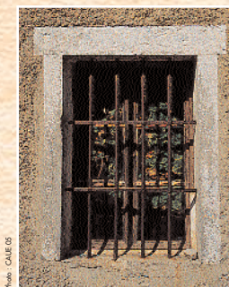
Fenêtre en rez-de-chaussée
