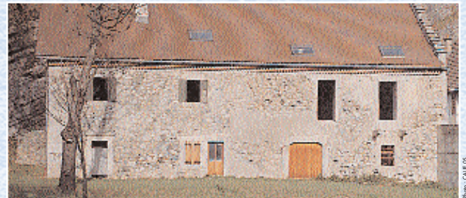
Réhabilitation d'un bâtiment ancien à Saint-Firmin
