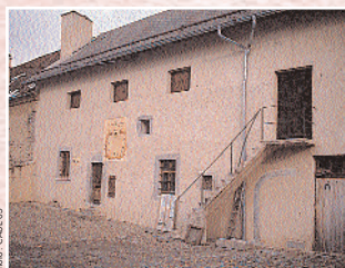
Réhabilitation dans le Champsaur
