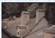
Toitures à Saint-Firmin
