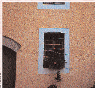
Réhabilitation de façade
