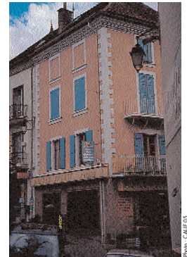
Traitement de façade en angle de rue
