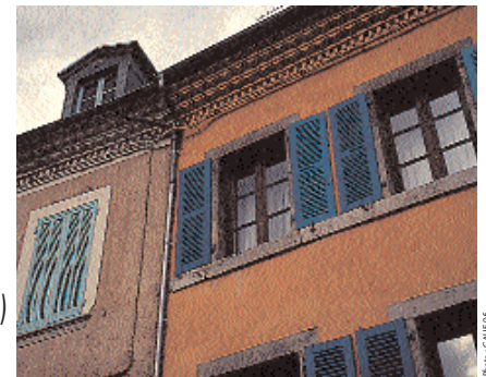
Génoises, enduits et menuiseries colorés.
