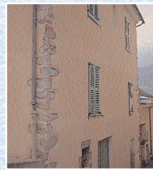
Réhabilitation de façade
