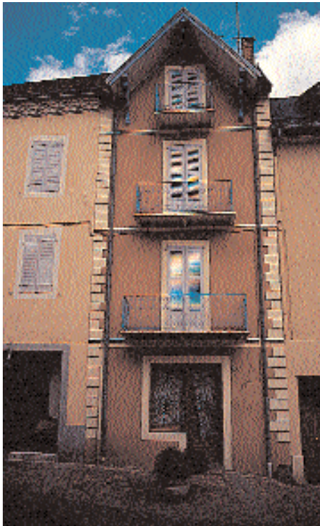
Saint-Bonnet, enduits colorés et décors de façades (encadrement de fenêtre, chaînages d'angle...)
