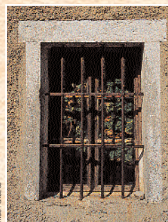
Fenêtre en rez-de-chaussée
